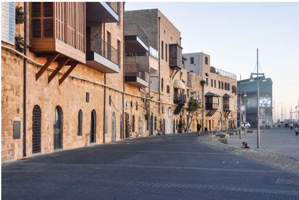
Fot. 26. Odbudowane domy wzdłuż nadbrzeża w Jaffie, w głębi stary port, fot. autor
