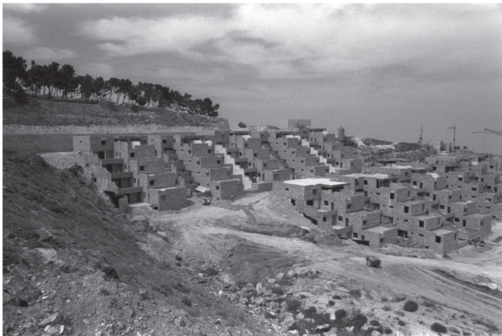
Il. 68. Budowa osiedla na wschodnim zboczku wzgórza French Hill w Jerozolimie, 1972, fot. Moshe Milner. Źródło: Government Press Office, State of Israel National Photo Archive, D553-078.
