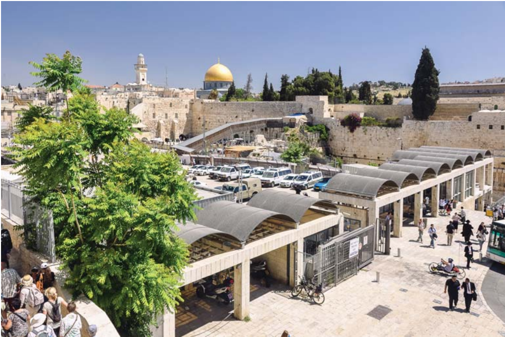
Fot. 47. Jerozolima. Ściana Płaczu i Kopuła na Skale, na pierwszym planie ogrodzenie i urządzenie kontroli dostępu, wzdłuż muru obudowany pomost, po którym turyści mogą wejść na Wzgórze Świątynne, fot. autor.
