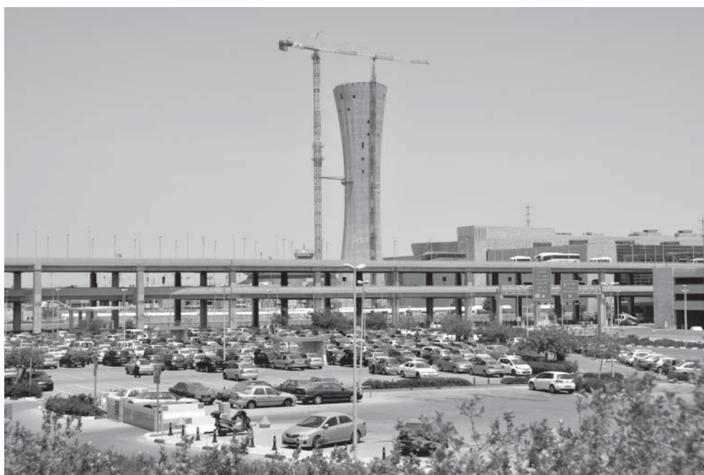
Il. 92. Budowa stumetrowej wieży kontroli lotów na lotnisku Ben Gurion (Pelleg Architects, 2014), 2014, fot. autor.
