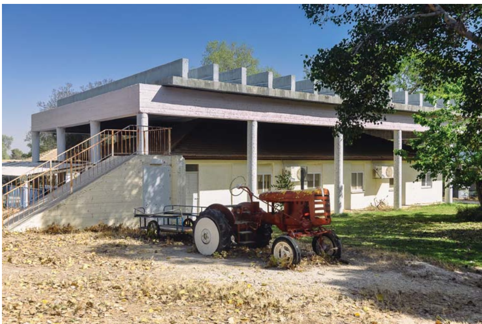
Fot. 8. Budynek szkoły w kibucu Yad Mordechai osłonięty żelbetową pokrywą, która go chroni przed rakietami wystrzeliwanymi z sąsiedniej Strefy Gazy, na pierwszym planie stary traktor – używany teraz jako zabawka, fot. autor.
