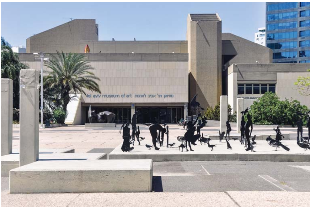
Fot. 75. Muzeum Sztuki w Tel Awiwie, budynek główny (Dan Eytan, 1971), fot. autor.
