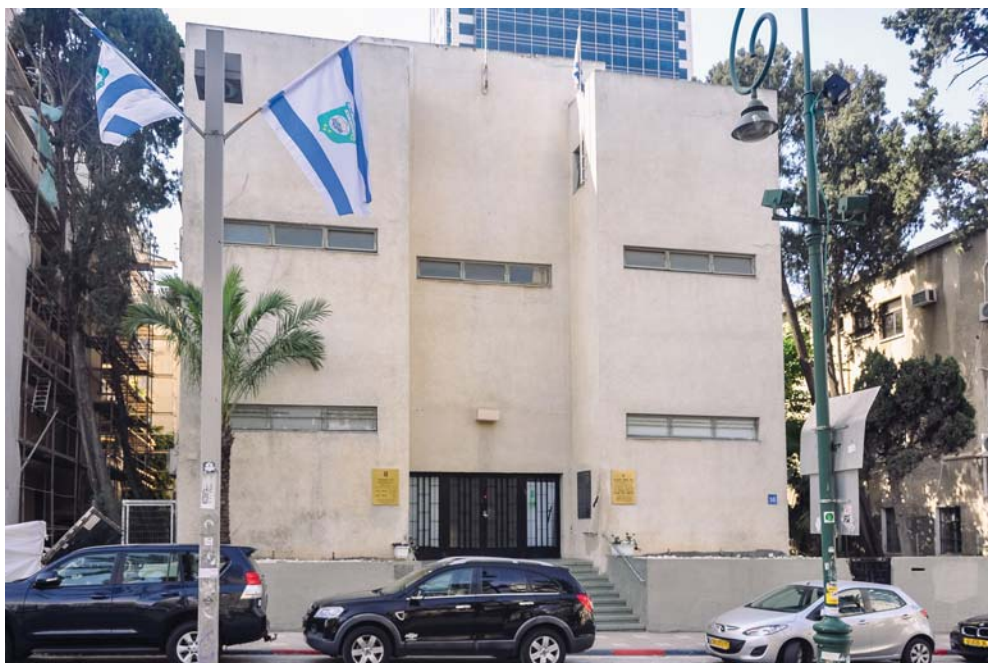
Fot. 13. Tel Awiw, Rothschild Boulevard 16, Dizengoff House, obecnie Independence Hall (przebudowa i adaptacja parterowego domu: Carl Rubin, 1932), fot. autor.
