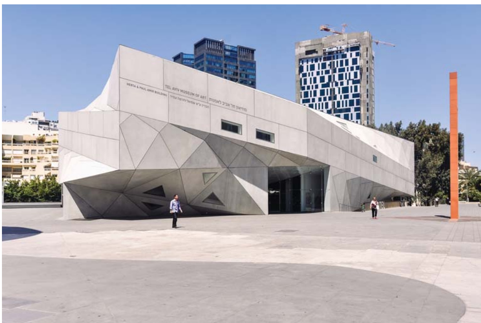
Fot. 76. Muzeum Sztuki w Tel Awiwie, rozbudowa (Preston Scott Cohen, 2010), fot. autor.
